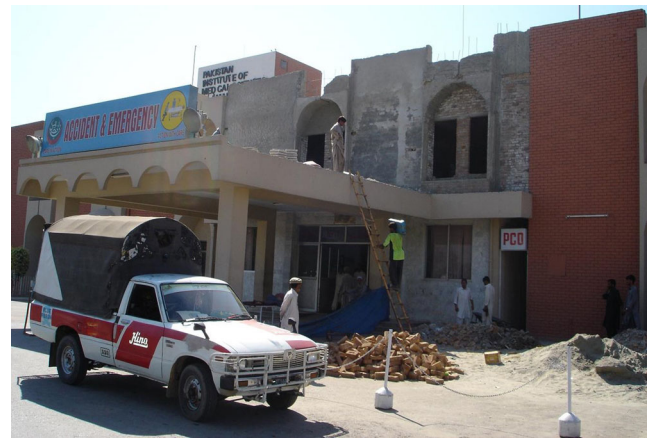
Fig. 3 Construction au Pakistan Institute of Medical Sciences de l'unité de réanimation médicale MICU en 2005
